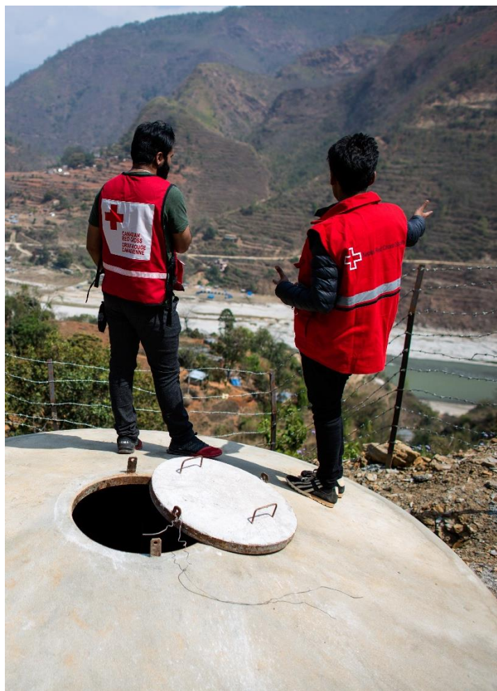
Nuevo sistema de suministro de agua construido por la Cruz Roja Nepalesa, en colaboración con la Federación Internacional, la Cruz Roja Canadiense y la Cruz Roja Danesa, en la remota aldea de Kharelthok, Nepal, afectada por un terremoto.
